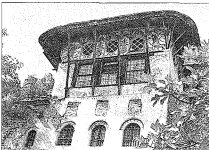
Duvar süslemeleri XVIII. yüzyıla ait olan karakteristik bir Osmanlı evi - Ergiri
